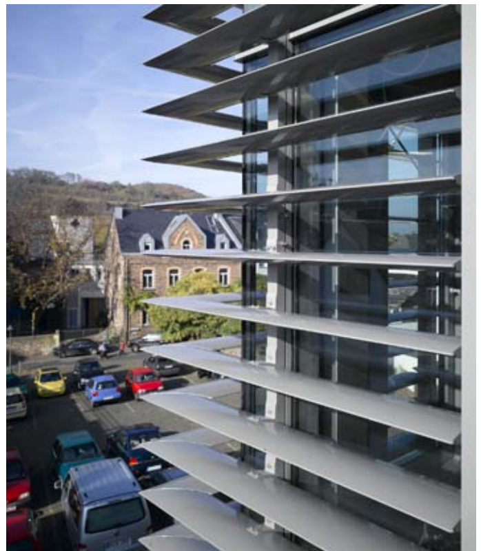
Sonnenschutzlamellen an der Verglasung im 2. OG
